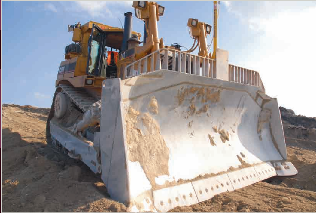
Kettendozer Caterpillar D 10 T: Länge 9,30 m, Höhe 4,40 m, Breite Räum schild 5,40 m, Schubvolumen 40 m 3 , Motorleistung 600 PS. In zehn Monaten wurden ca. 420.000 m 3 Material bewegt.
