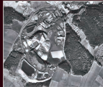
Auf diesem Luftbild von 1973 sind die Schlammteiche 1 (oben links, 1953–60), 3 (unten links, 1962–89) und 4 (unten Mitte, 1970–89) in Betrieb. Über dem Klärteich (Bildmitte) ist die Schachanlage Eichelberg zu erkennen. Foto: Bayer. Vermessungsverwaltung
