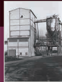
Die neue Schlackenmühle, 2001
