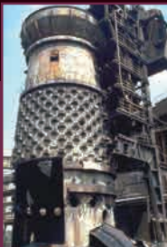
Abbruch Hochofen IV, 1992. Foto: Armin Fließ
