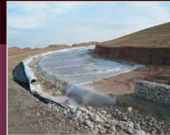
Über dem Deponiematerial wurden ca. 228.000 m 2 Kunststoffdichtungsbahn verlegt, darüber eine Drainagebahn, dann folgte der Rekultivierungsboden.
