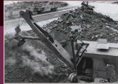
Zerkleinern der Schlacke an der Schlackenhalde
