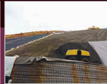
Steilböschungen werden mittels bewehrter Erde und vorgesetzter Gabionenwände abgefangen.
