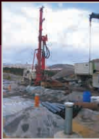
Bohrungen an den Schlammteichen 3, 4 und 5 (2007). Die Bohrkern wurden analysiert.
