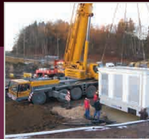
Sofortmaßnahmen ab Oktober 2005: Stützfußschüttung an der Südböschung, Umzäunung des Geländes sowie Neubau von Elektrizitätsversorgung und Sickerwasserreinigung
