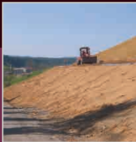
Sofortmaßnahmen ab Oktober 2005: Stützfußschüttung an der Südböschung, Umzäunung des Geländes sowie Neubau von Elektrizitätsversorgung und Sickerwasserreinigung
