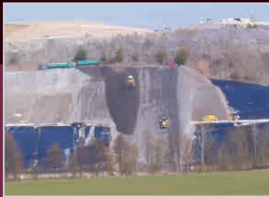
Profilierung und Abdichtung im Südbereich, 2010
