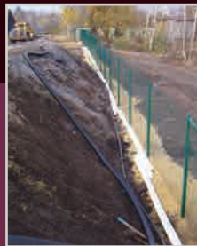
Sofortmaßnahmen ab Oktober 2005: Stützfußschüttung an der Südböschung, Umzäunung des Geländes sowie Neubau von Elektrizitätsversorgung und Sickerwasserreinigung
