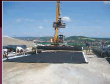
Über dem Deponiematerial wurden ca. 228.000 m 2 Kunststoffdichtungsbahn verlegt, darüber eine Drainagebahn, dann folgte der Rekultivierungsboden.
