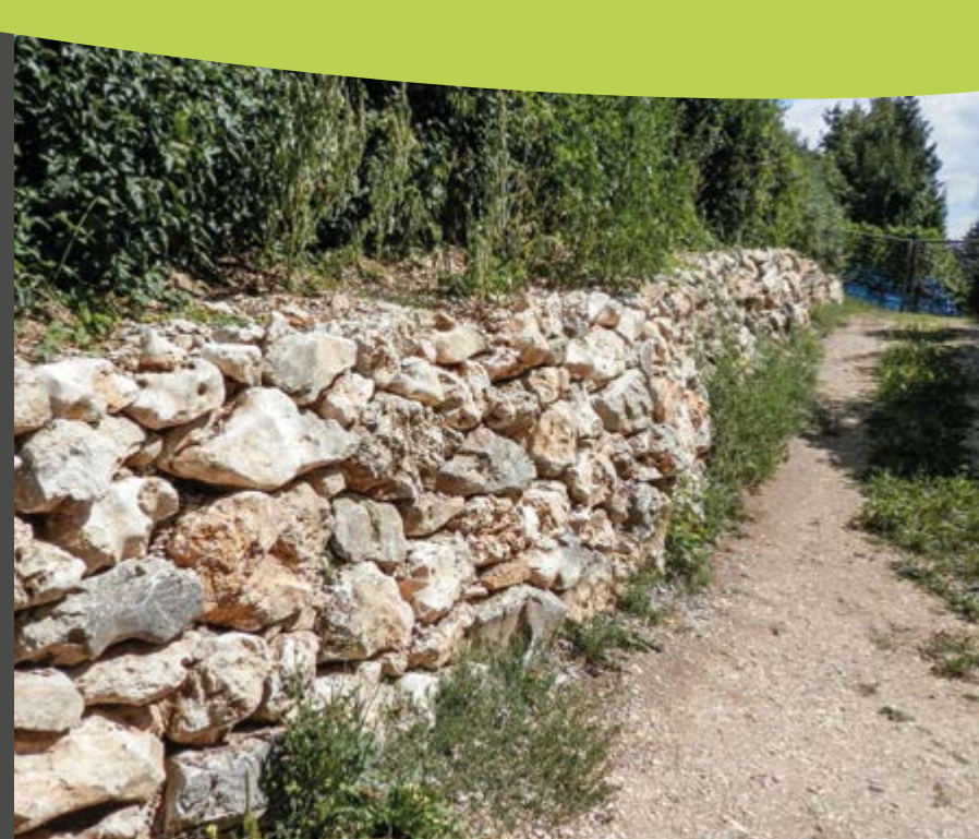
Wiederaufbau einer Trockenmauer bei Winzer als Lebensraum; Förderung über LNPR
