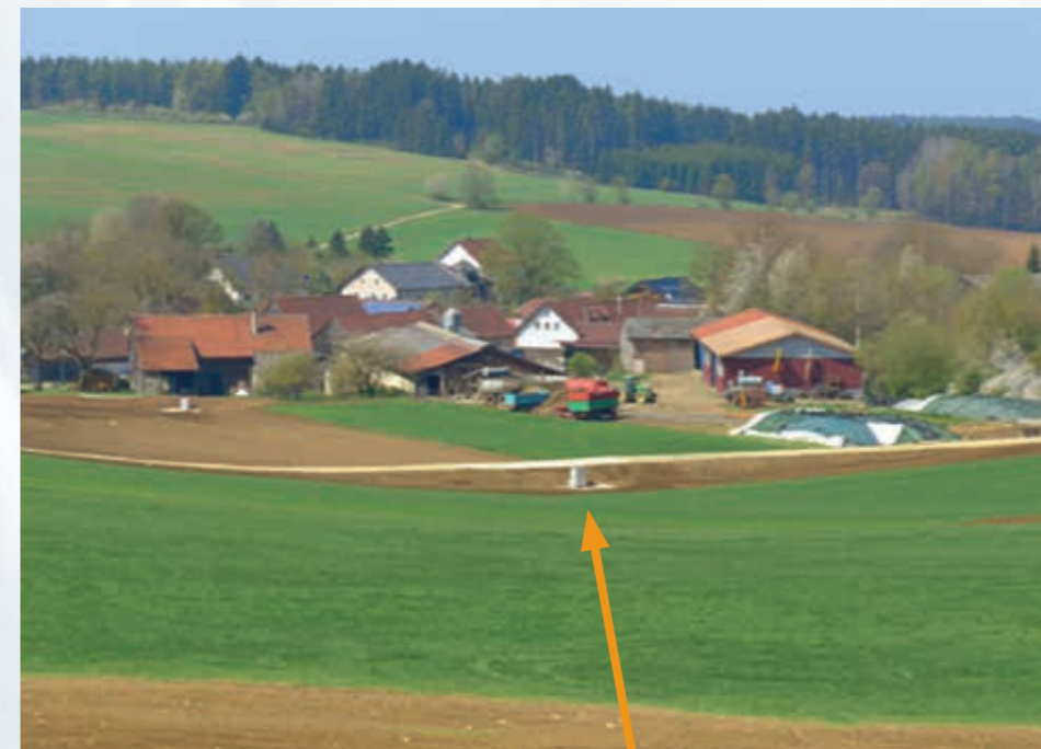
◀ Blick auf die Ortschaft Hagenohe, Stadt Auerbach im Landkreis Amberg-Weilburg mit Rückhaltebereich. Der Mönch sichert den gedrosselten Abfluss (Foto: Amt für Ländliche Entwicklung Oberpfalz)
