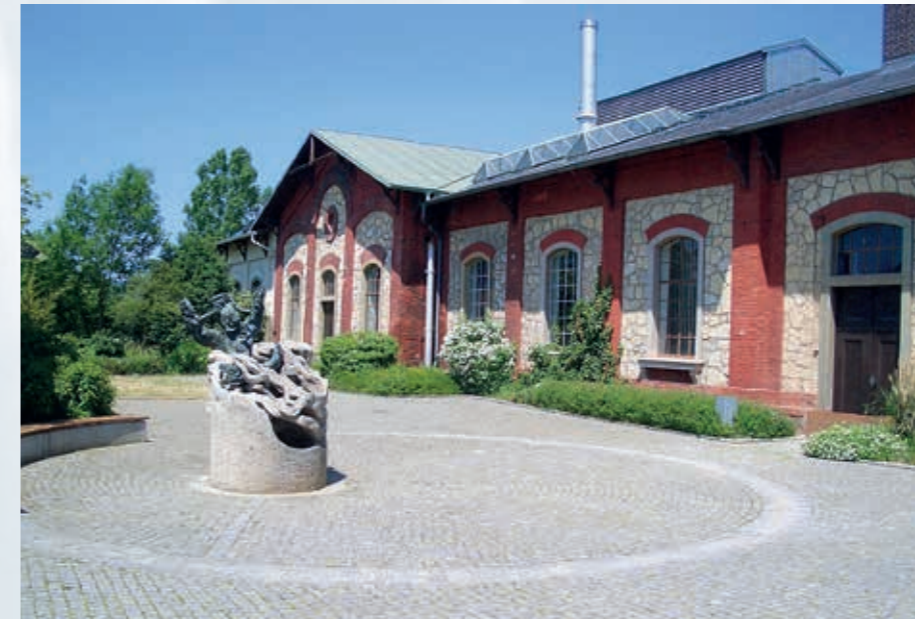
▲ Historisches Maschinenhaus mit Naturbrunnen im Wasserwerk Sallern (Foto: Hanno Meier).
