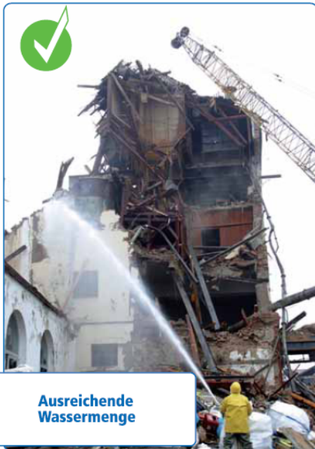
Befeuchtung Abbruchmaterial gegen Staubverwehung
