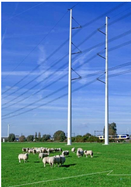
Abbildung 4: Wintrack-Pylon (Doppelpylon)
