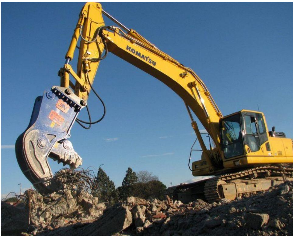
Abbildung 2.2: Bagger mit Abbruchzange (Pulverisierer)
