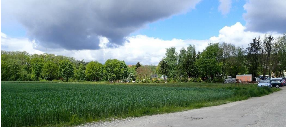
Blick von Ettmannsdorf Ost (Ringstr. 7) in Richtung Nordweste; im Hintergrund links die Mastspitze von Mast 10 der 380 kV-Bestandsleitung
