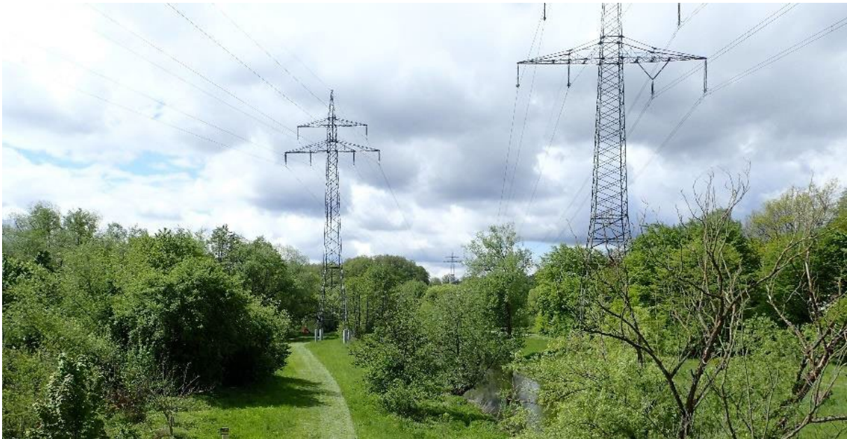
Blick von der Naabbrücke bei Ettmannsdorf Richtung Südwesten auf die beiden Leitungstrassen: rechts Mast 11 der 380 kV-Bestandsleitung; links Mast 14 der 110-kV-Bestandsleitung
