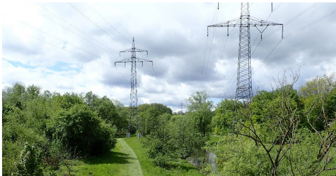
Abbildung 27: Blick von der Naabbrücke bei Ettmannsdorf Richtung Südwesten auf die beiden Leitungstrassen: rechts Mast 11 der 380 kV-Bestandsleitung; links Mast 14 der 110-kV-Bestandsleitung
