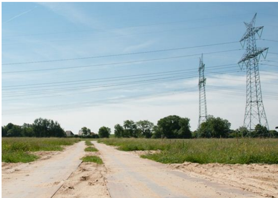
Abbildung 16 Abbildung 44 : Beispiel für eine temporäre Mastzufahrt
