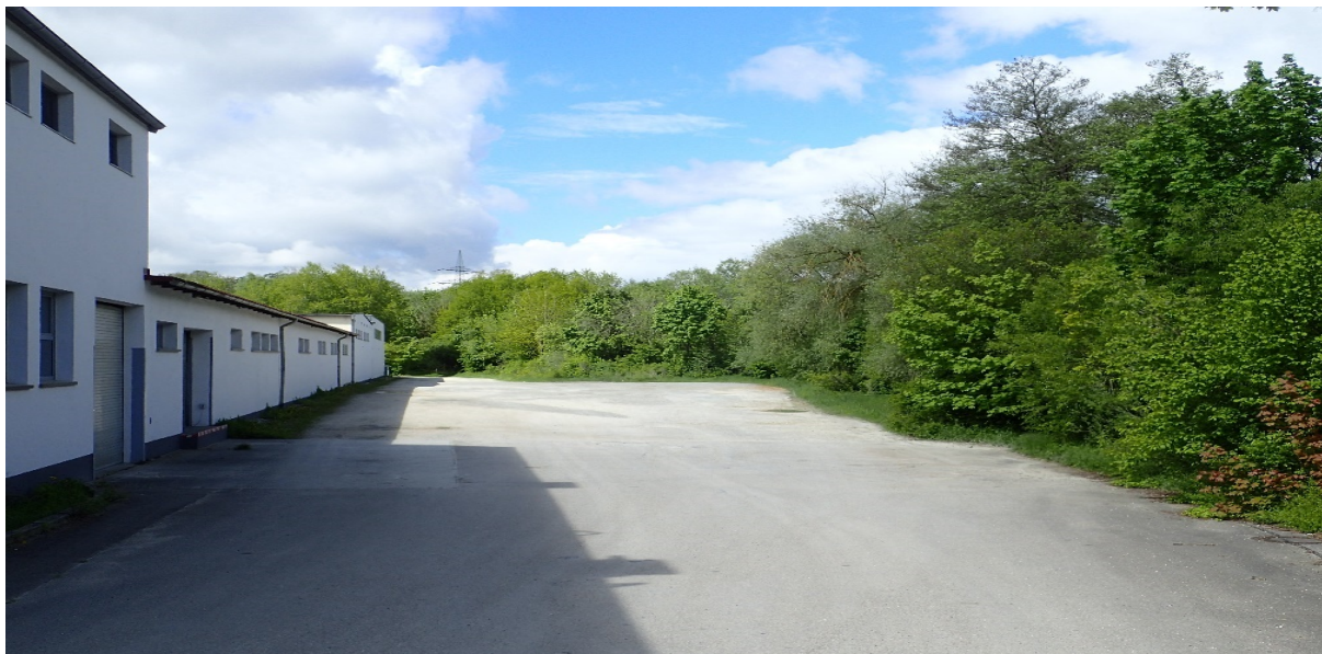
Abbildung 29: Blick von Ettmannsdorf Ost (In der Trift 1) Richtung Westen, im Hintergrund Mastspitze von Mast 10 der 380 kV-Bestandsleitung
