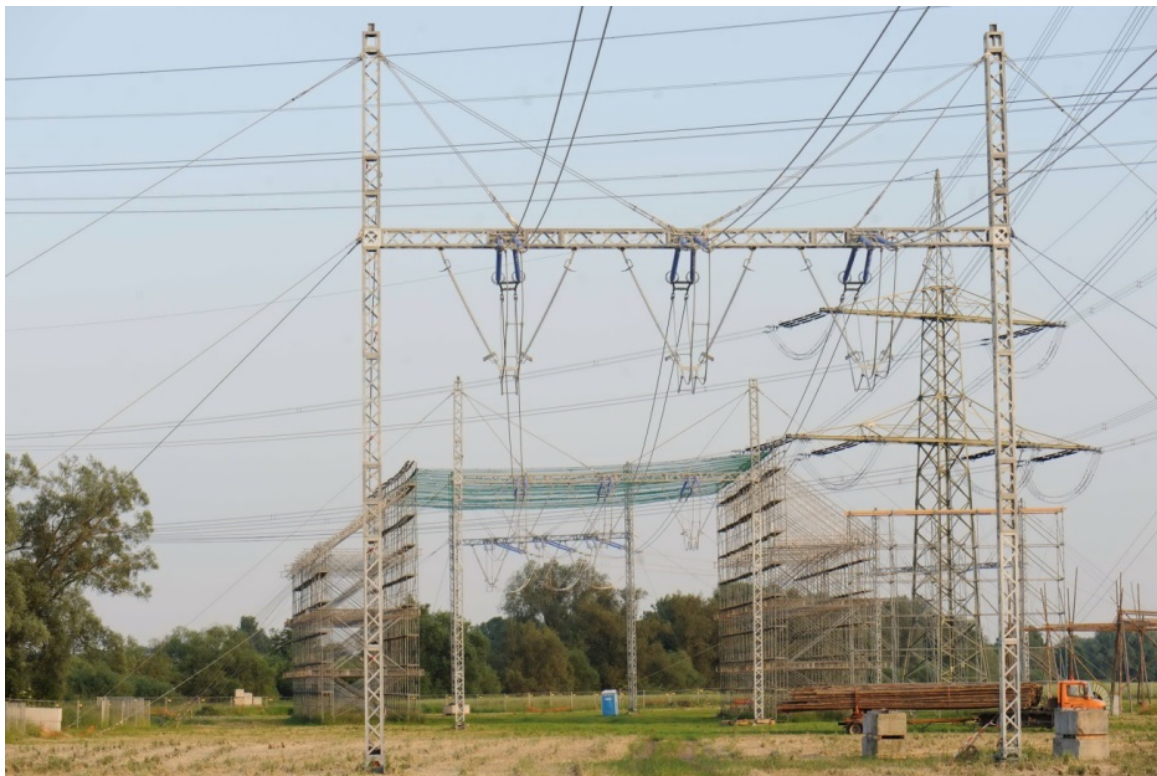
Abbildung 14 Abbildung 42 : 380-kV-Freileitungsprovisorium für ein System mit errichtetem Schutzgerüst
