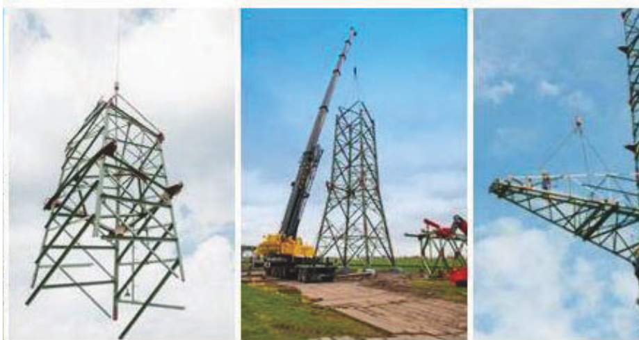
Abbildung 20 Abbildung 48 : Mastmontage mittels Mobilkran
