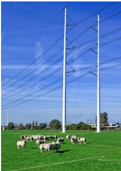
Abbildung 4: Wintrack-Pylon (Doppelpylon)
