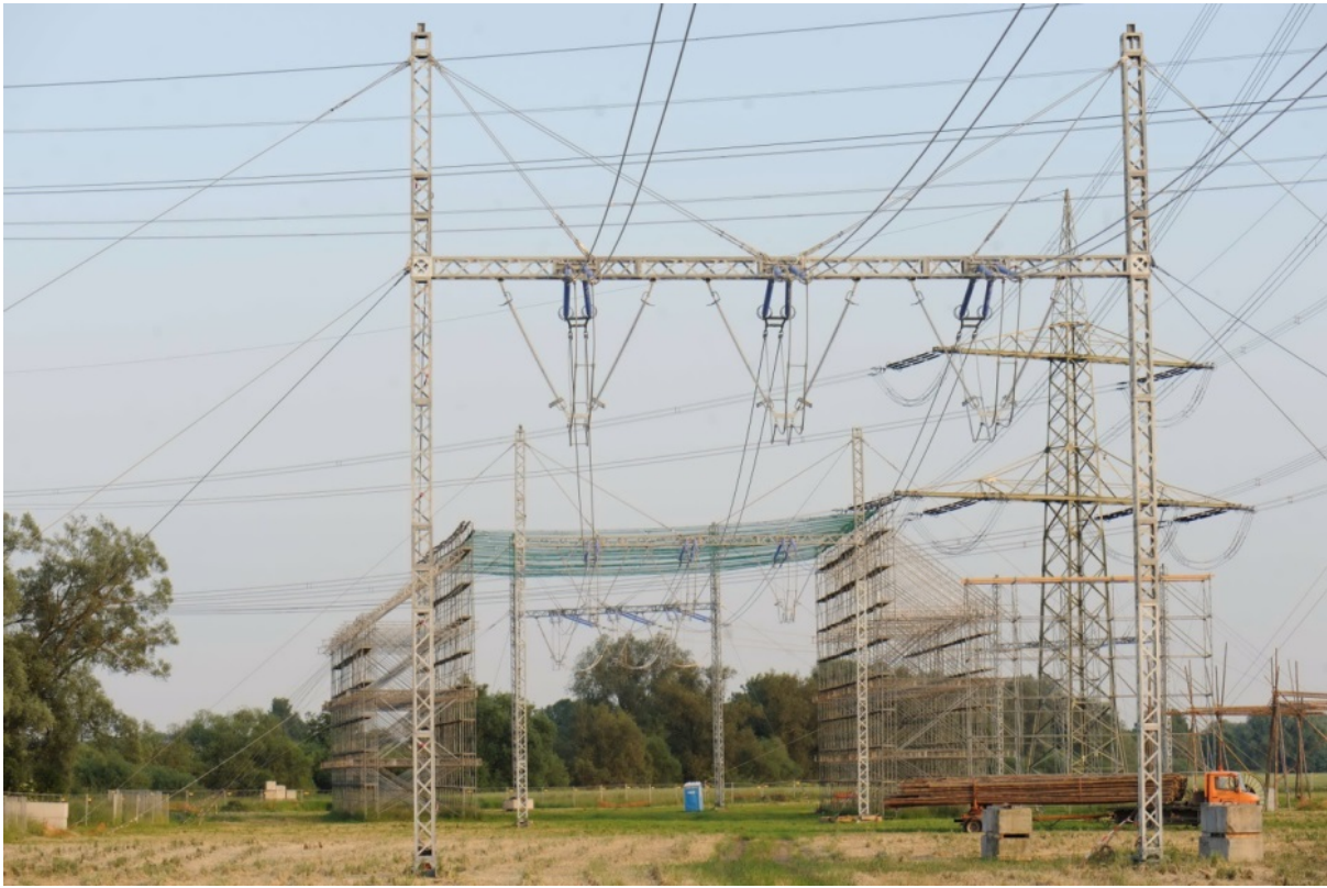
Abbildung 9: 380-kV-Freileitungsprovisorium für ein System mit errichtetem Schutzgerüst
