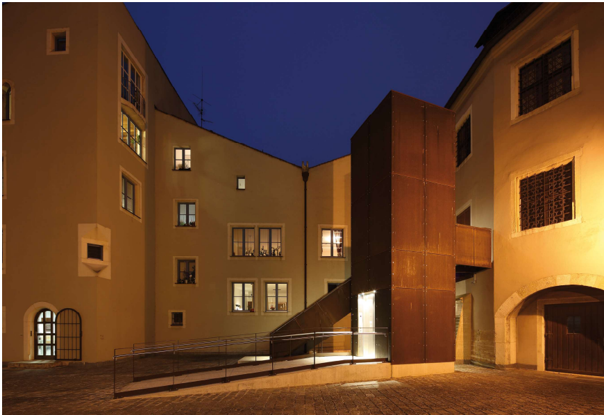
Aufzug- und treppenanlage im Fechthof
