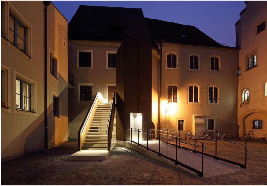
Aufzug- und treppenanlage im Fechthof
