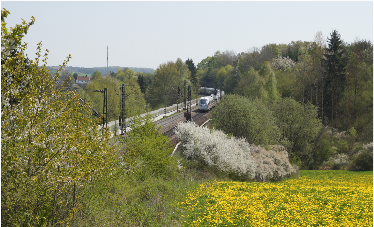
Schallschutzwand südwestlich des Kugelbergweges
