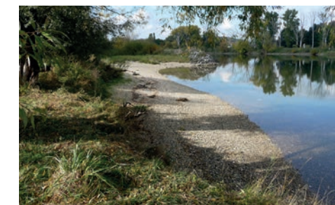
Beispiel eines Uferrückbaues an der Donau bei Pfatter
