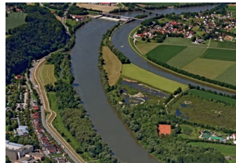
Wasserkraftwerk Bad Abbach (HD)
