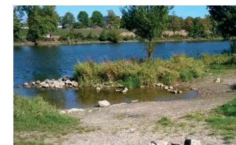
Umgesetzte Maßnahme am Unteren Wöhrd in Regensburg
